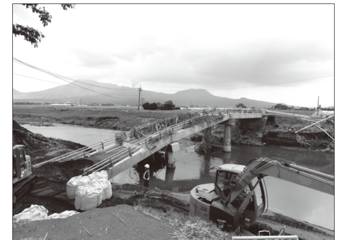
●同じ河川に架橋され倒壊・流出した橋梁の被害状況
