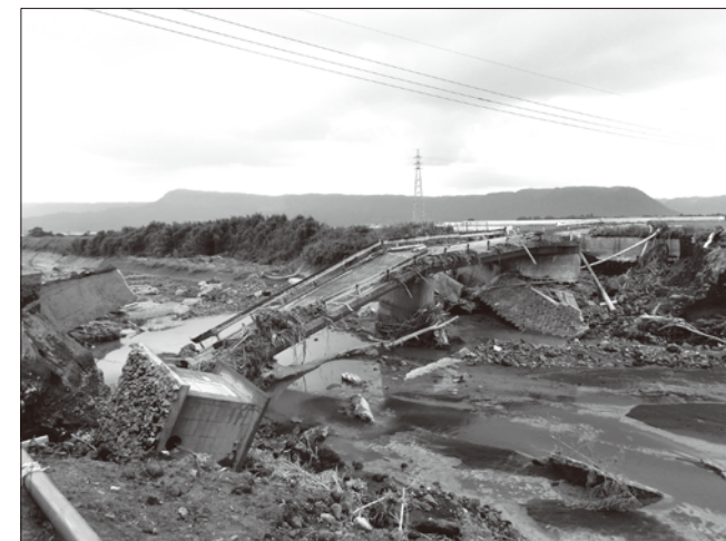
●同じ河川に架橋され倒壊・流出した橋梁の被害状況
