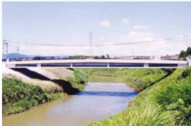
跡ヶ瀬大橋(熊本県)
