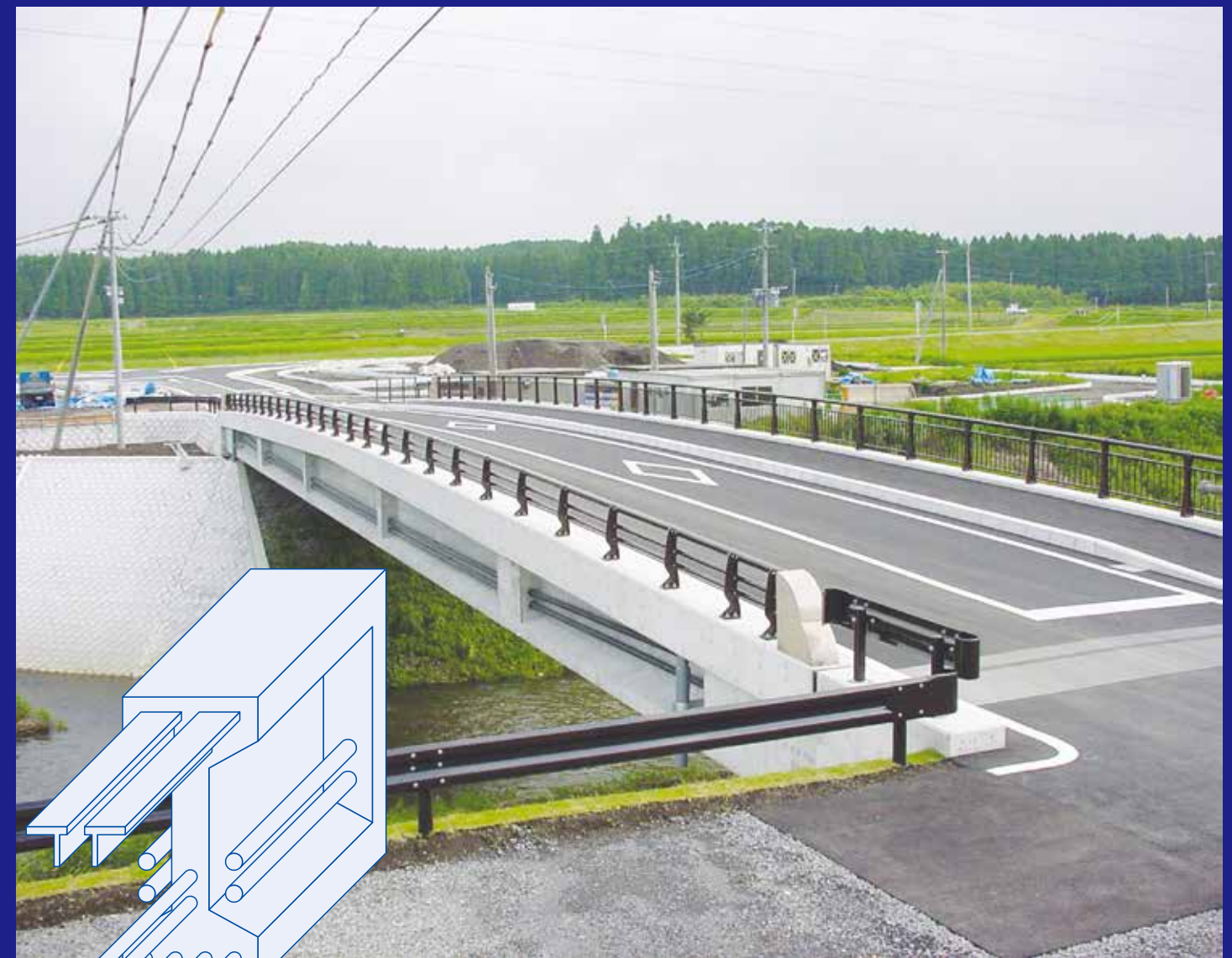
施工事例／跡ヶ瀬大橋(熊本県)
