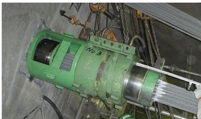
図表 7.3 F型チェア使用の緊張状況と部品構成例
