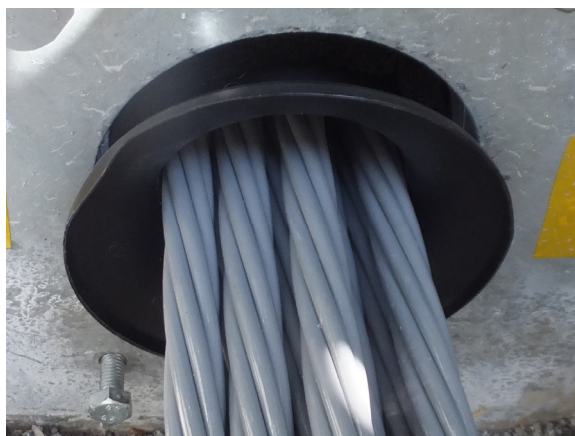
図 6.12 防食PC鋼より線の挿入状況
