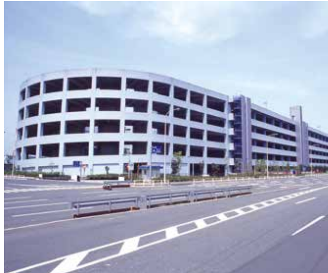
横浜港国際流通センター
