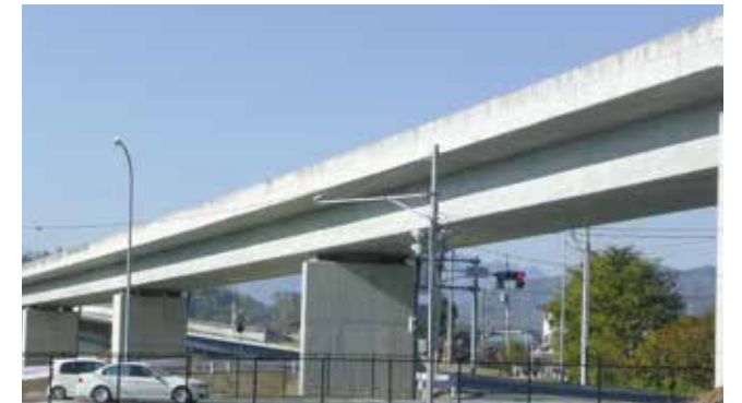
皆野橋(岐阜県)外ケーブル併用連続箱桁橋
