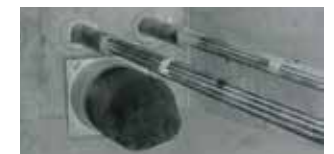
外ケーブル状況
