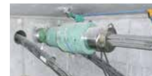
外ケーブルの緊張
