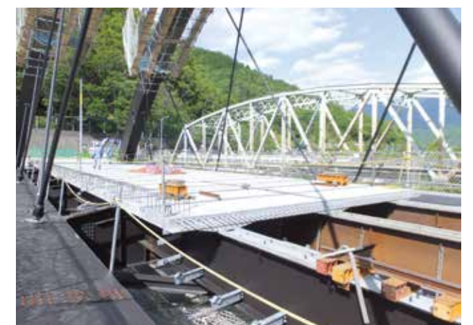
早川橋（山梨県）ニールセンローゼ橋 PCaPC床版（φ15.2mmSC-S採用）
