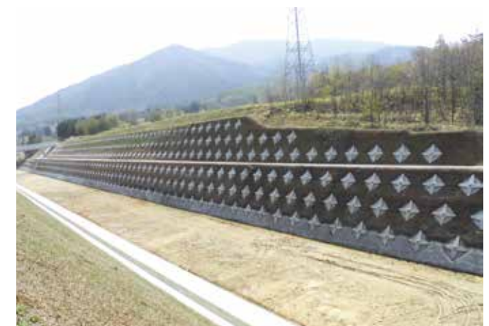
下綾織法面工事 (岩手県)
