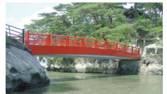
渡月橋（宮城県）プレテンション中空床版桁橋 （φ15.2mmSC-S及び塗装鉄筋採用）
