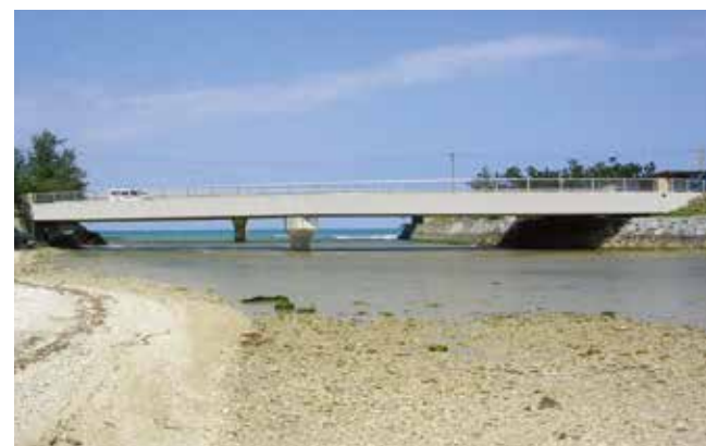
屋嘉比橋（沖縄県）ポストテンション中空床版桁橋 （12-φ12.7mmSC-S及び塗装鉄筋採用）
