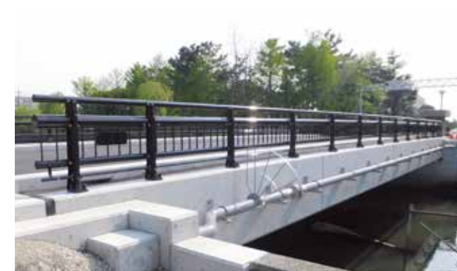
吾妻大橋（千葉県）プレテンション中空床版桁橋 （φ15.2mmSC-S及び塗装鉄筋採用）
