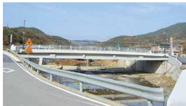
CHA HANG BRIDGE(韓国)SPC合成桁橋
