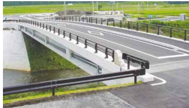
跡ヶ瀬大橋(熊本県)SPC合成桁橋
