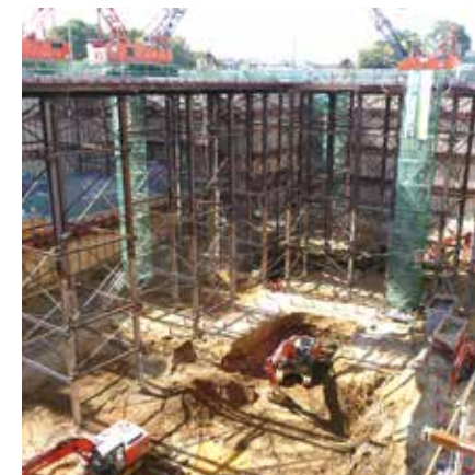
練馬清掃工場建替工事
