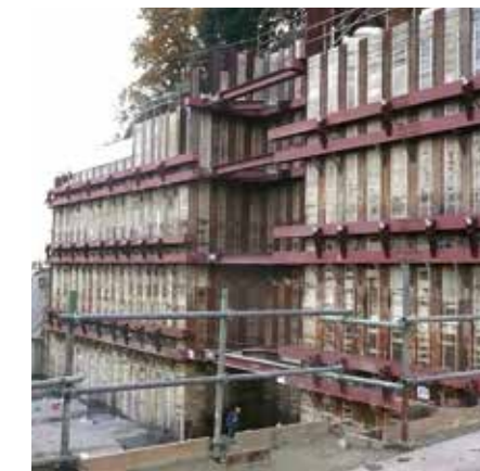
ネクスコート黒川新築工事
