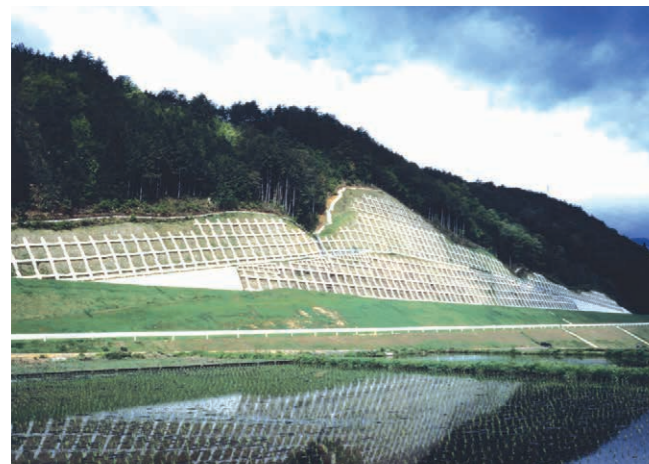
PCフレーム 東海北陸自動車道洞工(岐阜県)
