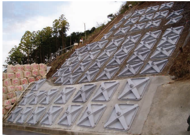
スーパーメタルフレーム 鴨川道路災害復旧工事(千葉県)
