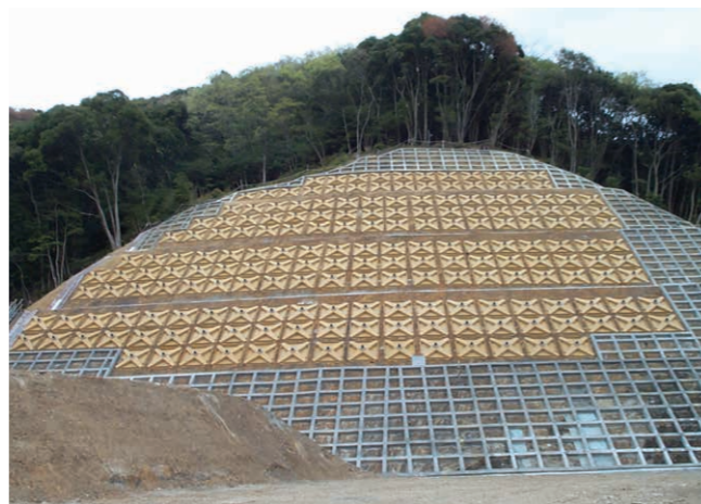
スーパーメタルフレーム 第2東名工事(静岡県)
