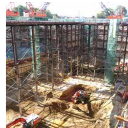
練馬清掃工場建替工事
