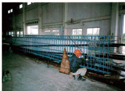
エポキシ樹脂塗装鉄筋とポリエチレンシース組立状況
