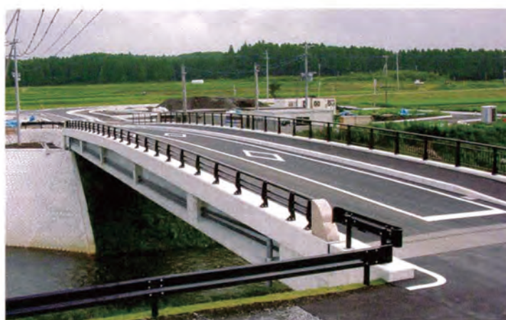
熊本県 跡ヶ瀬大橋
