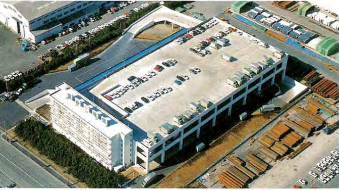
9 福山通運(株)市川支店ターミナル
