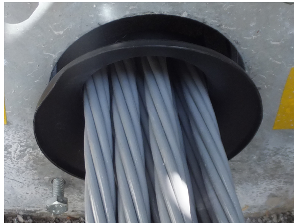
図 6.12 防食PC鋼より線の挿入状況
