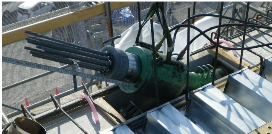
図表 7.2 カーブチェア使用の緊張状況と部品構成例
