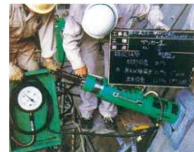
緊張は、グラウトが所定の強度に達した後、品質保証試験により変位特性を確認し、施工計画に示された定着時緊張力で定着します。
