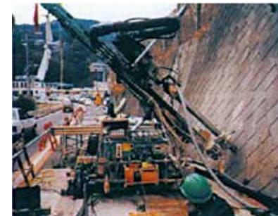
アンカーの削孔は計画された削孔径・削孔傾角で所定の削孔長まで削孔します。また、削孔終了時に孔内を清水で周囲の地盤を乱すことがないように洗浄します。
