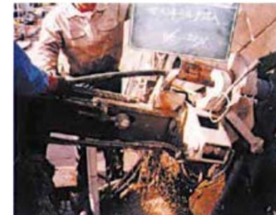
一次注入はテンドンを挿入する以前に、削孔水との置換えとグラウト充てんを目的として行うことを原則とします。グラウトと削孔水との完全な置換えが最も大切です。
