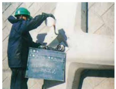
緊張および定着されたアンカー頭部を、設計図書に従って背面ならびに頭部の処理を行います。
