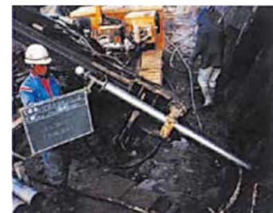
テンドン挿入後は加圧注入を原則とします。ドリルパイプ引抜き後、補充注入を行います。
