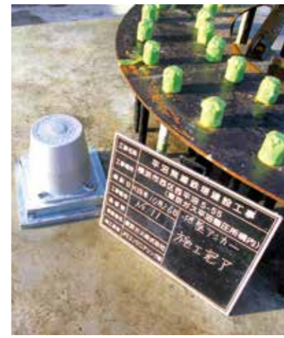
アンカー施工
