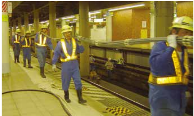
アンカー tendon の運搬
