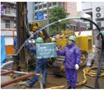
アンカー挿入状況
