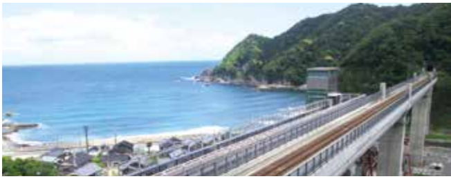
余部鉄橋「空の駅」全景
