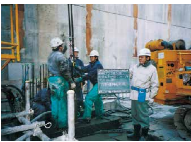
アンカー挿入状況
