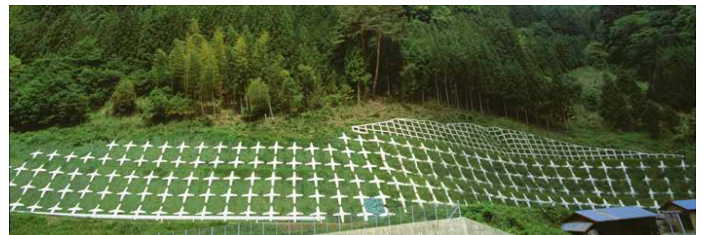
スーパーメタルフレーム(左)／PCフレーム(右) 三遠南信道草木改良工事(静岡県)
