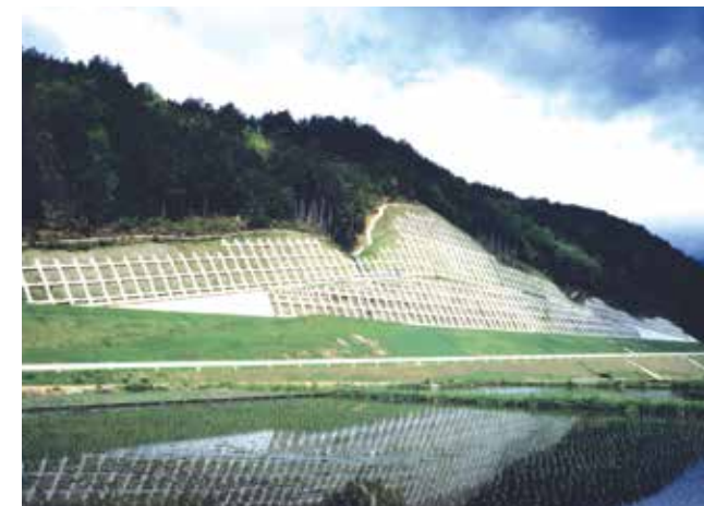
PCフレーム 東海北陸自動車道洞口工事(岐阜県)
