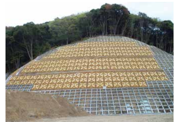
スーパーメタルフレーム 第2東名工事(静岡県)
