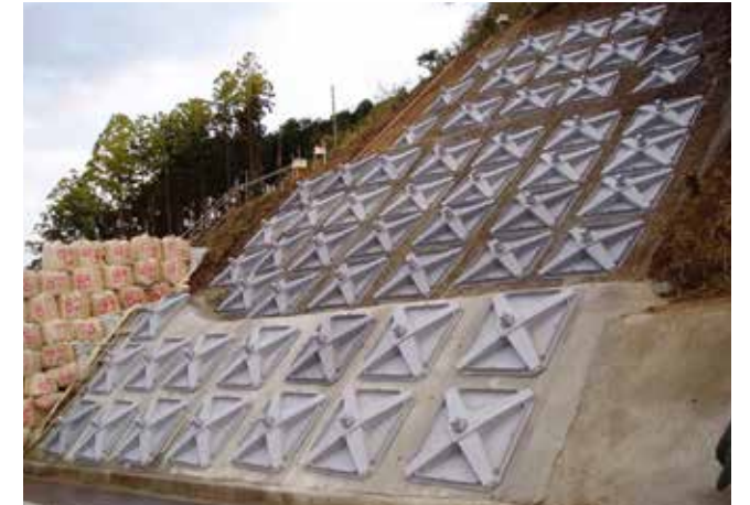
スーパーメタルフレーム 鴨川道路災害復旧工事(千葉県)
