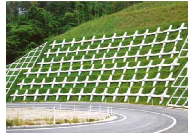
PCフレーム 一般県道特殊改良工事(鳥取県)
