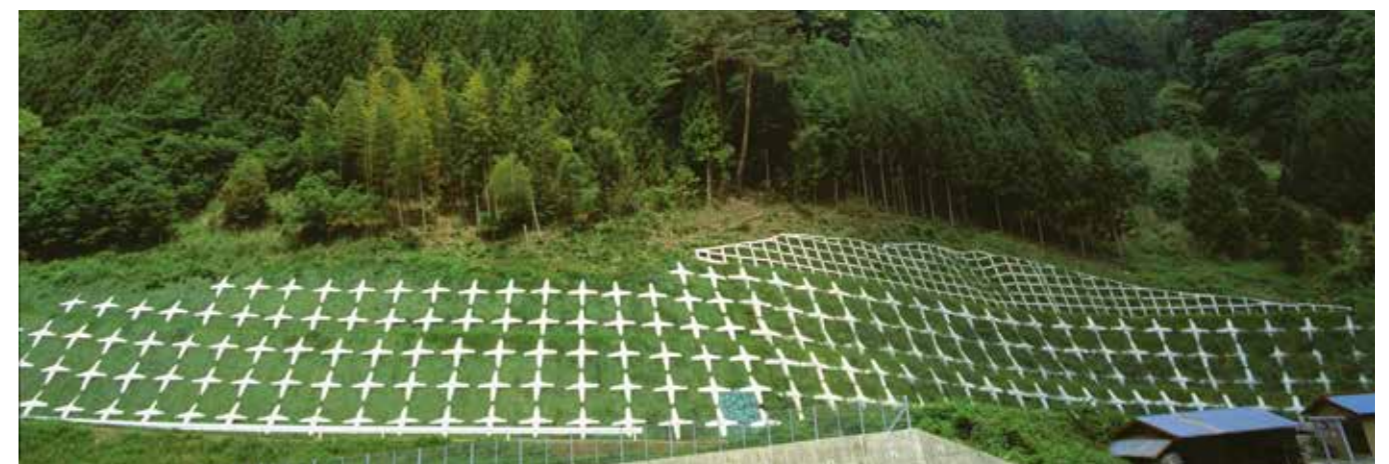
スーパーメタルフレーム(左)/PCフレーム(右) 三遠南信道草木改良工事(静岡県)
