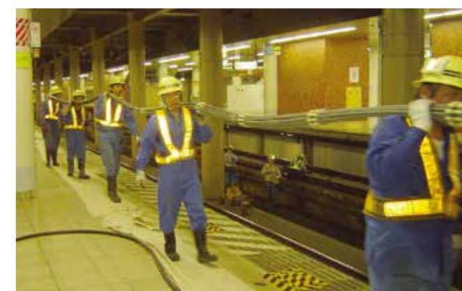
アンカーテンダンの運搬
