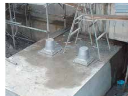
新設地中梁にアンカー打設
