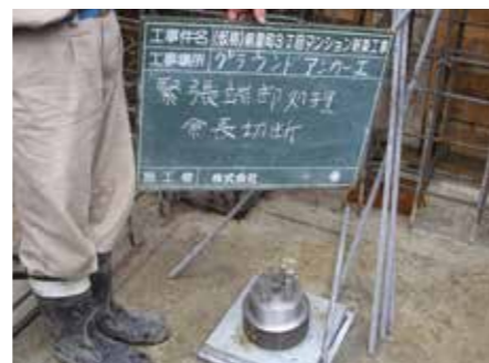
緊張端部処理
