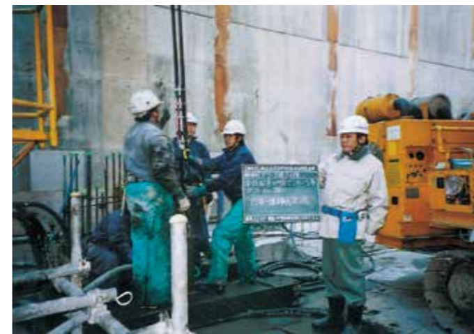
アンカー挿入状況
