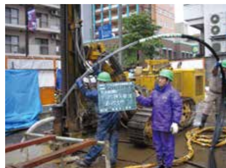
アンカー挿入状況
