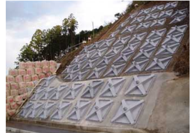
鴨川道路災害復旧工事(千葉県)
