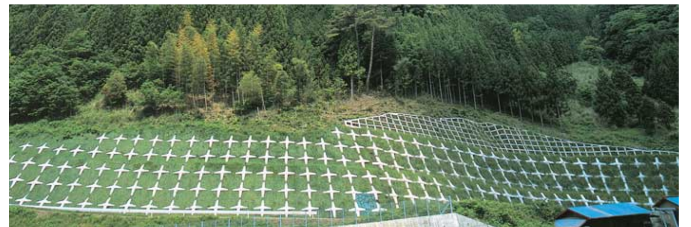
三遠南信道草木改良工事(静岡県)
