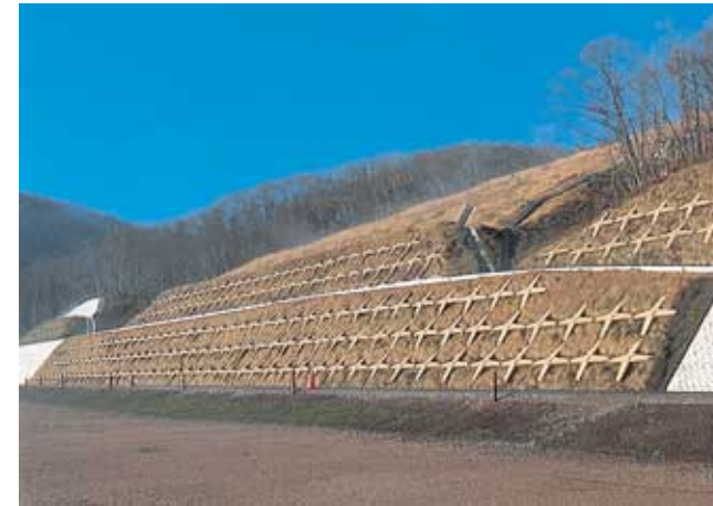
東海北陸自動車道古谷工事(岐阜県)
