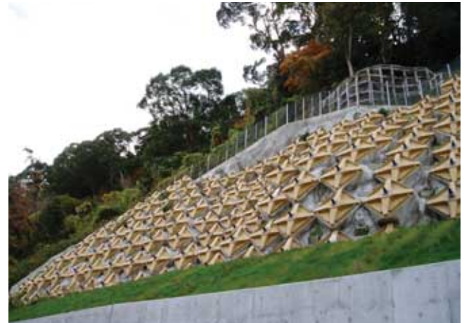
国道135号線道路改修工事(静岡県)
