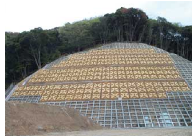
第2東名工事(静岡県)
