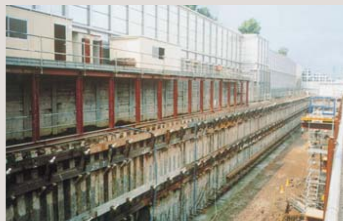
目黒給水所築造工事
