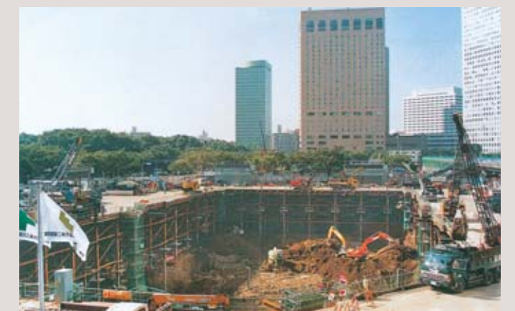
東京都第二本庁舎建設工事
