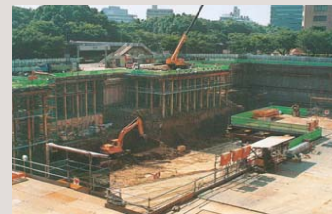
東京都第一本庁舎建設工事
