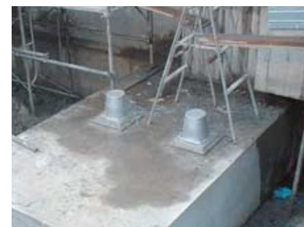
新設地中梁にアンカー打設
