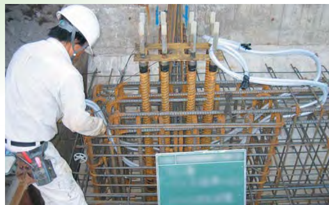
1 基礎工事(アンカーフレームセット状況)
