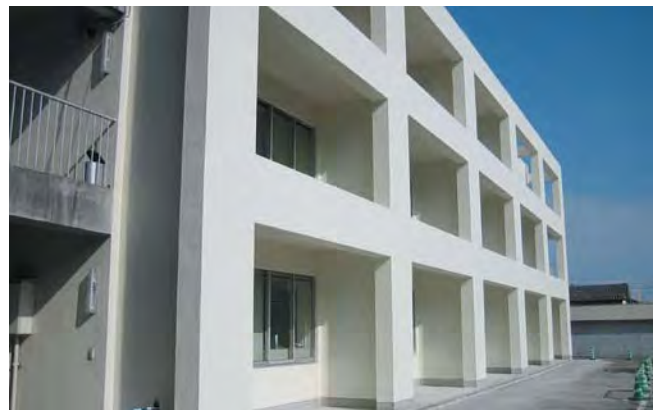
8 PC工事完了
