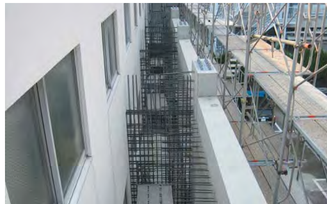
7 既存建物とのスラブ接合状況
