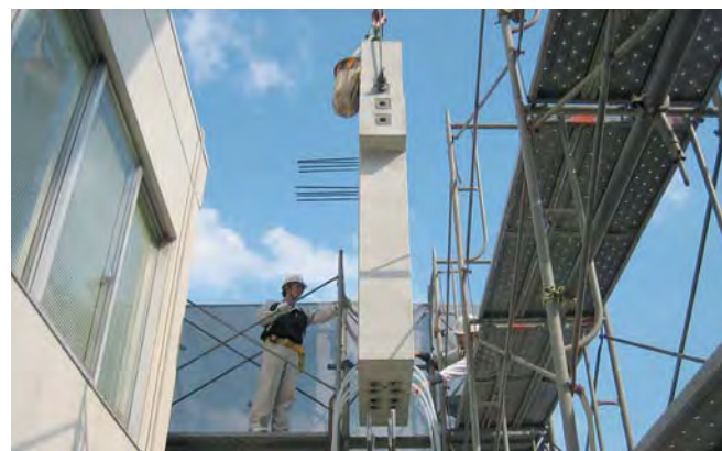
3 PC柱建方状況
