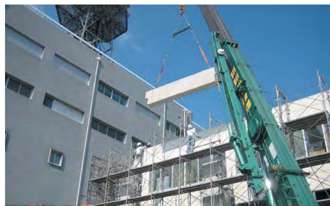
5 PC梁架設状況
