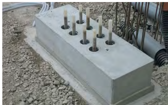
2 柱脚ブロック据付状況
