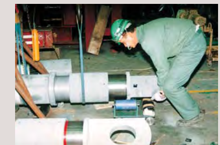
5. 緊張側金物取付
