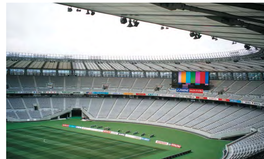
味の素スタジアム(東京都:吊り屋根構造)
