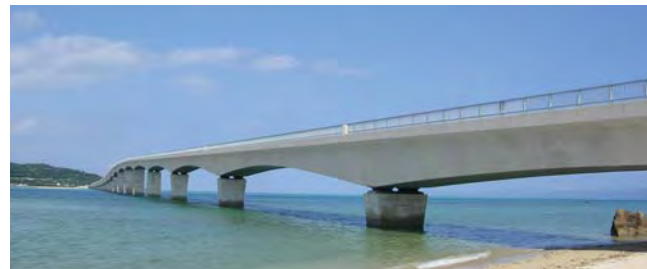
古宇利大橋(沖縄県:連続箱桁橋)
