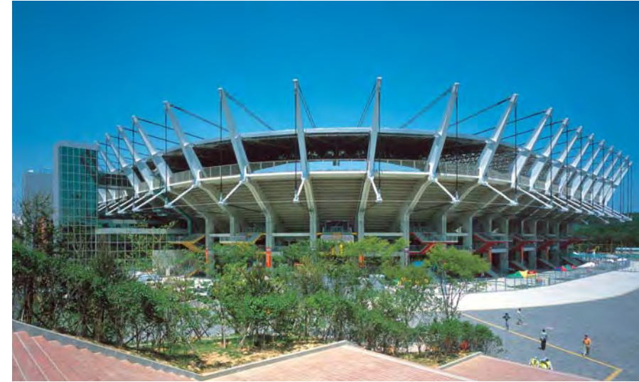
ウルサンスタジアム(韓国:吊り屋根構造)
