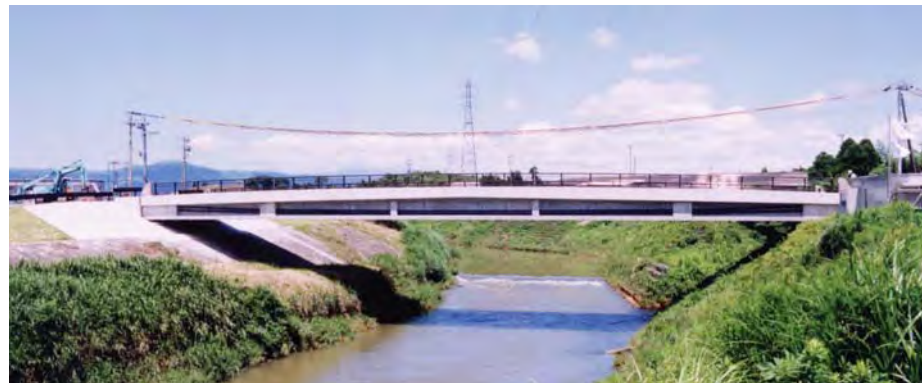
跡ヶ瀬大橋(熊本県:SPC単純桁橋)
