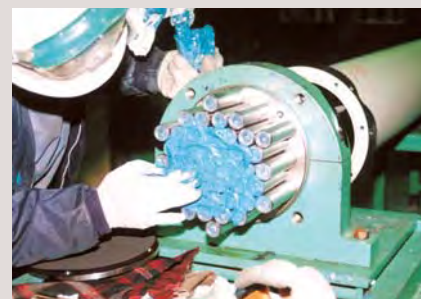
2. 圧着グリップ端部A0防食処理
