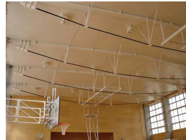
山形ニュータウン小学校屋内運動場(山県:張弦ケーブル)
