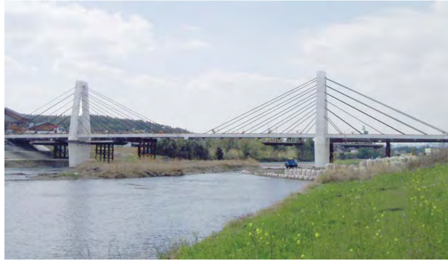
菊池川歩道橋(熊本県:斜張橋)
