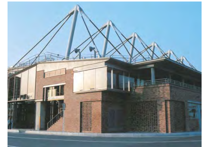
下関地方卸売市場唐戸市場(山口県:吊りケーブル)
