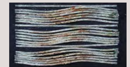
「亜鉛めっきPC鋼より線」2,000時間試験後の内部状況
