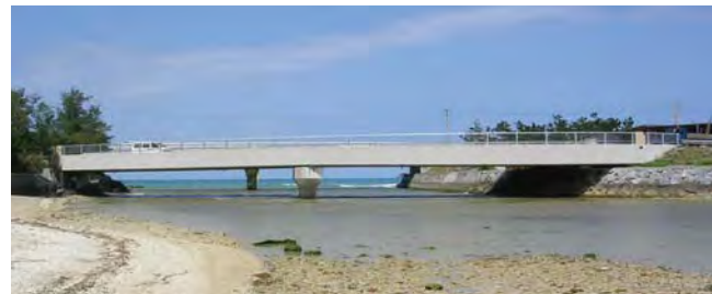
屋嘉比橋(沖縄県:単純桁橋)
