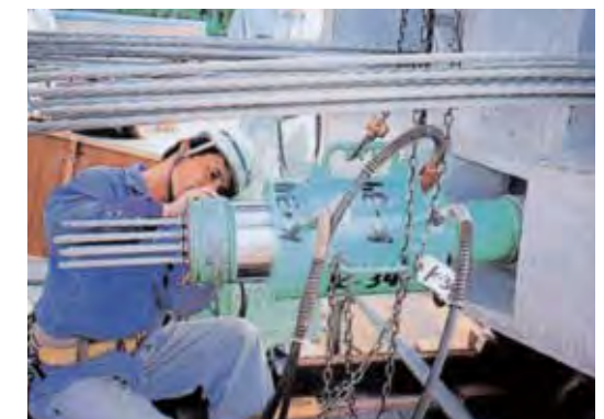
4.SCストランド緊張力導入作業
