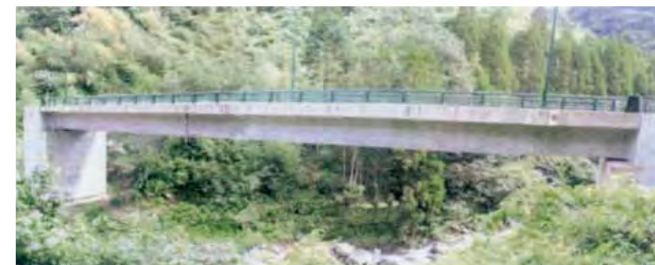
戸越鹿目2号橋 (熊本県:場所打ち箱桁橋)
