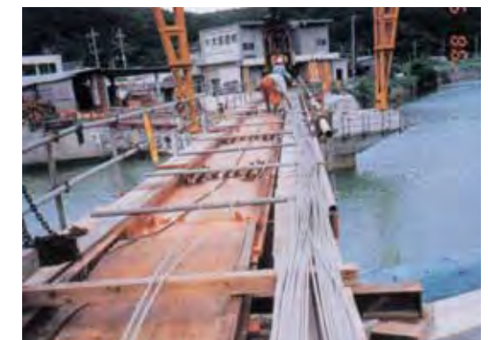
2.SCストランドの切断状況
