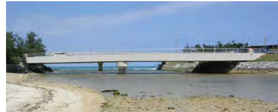
屋嘉比橋 (沖縄県:単純桁橋) 土木学会西部支部「技術賞」受賞
