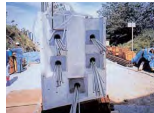
3.SCストランドが挿入された状態のプレキャスト桁
