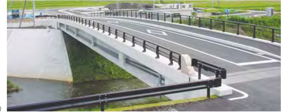
跡ヶ瀬大橋 (熊本県:SPC単純桁橋)
